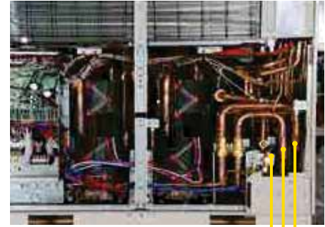
Likit Borusu Emme Gaz Borusu Basma Gaz Borusu
